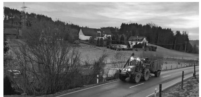
Die Vorbereitungen für den Bau des Radweges sind in vollem Gange. Letzte Woche wurden Büsche und Bäume gerodet, damit pünktlich im Frühjahr mit dem Bau begonnen werden kann.
