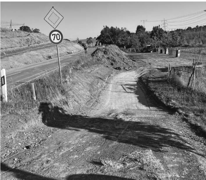
Foto vom 13.06.23: Der Streckenabschnitt mit den wohl größten Erdbewegungen. Links der Hang, in welchen die Straße verlegt wird und rechts sieht man bereits den Verlauf des Radwegs.
