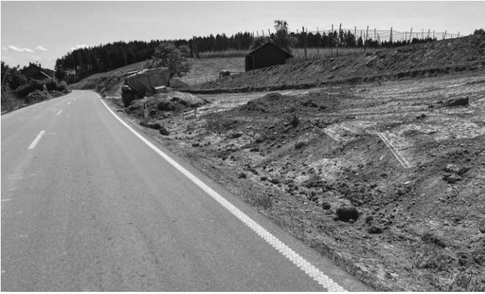
Foto vom 06.06.23: Hübschenberg: Planierungsarbeiten am Hang für die Straßenverlegung.
